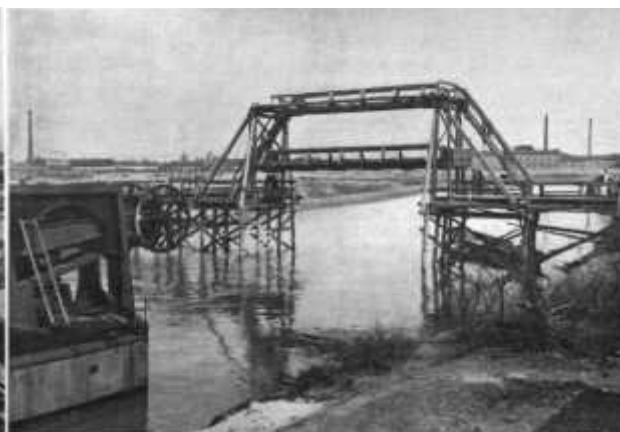
3. ábra. Kvassay-zsilip építés alatt
