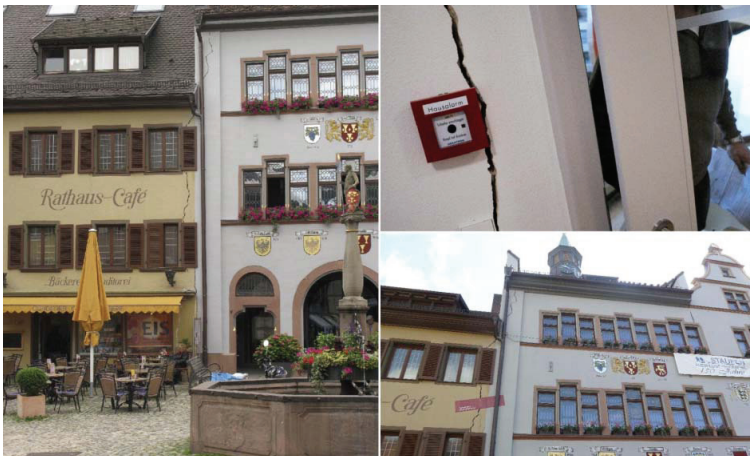
4. ábra. Balul végződött talajszondás hőszivattyú-telepítés Staufenben: a városháza környékén megemelkedett talaj megrepesztette az óváros sok épületének falát.
