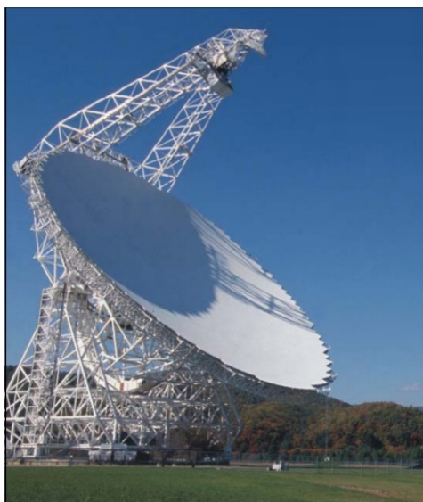
A 100 m-es Green Bank Teleszkóp USA 2. ábra
