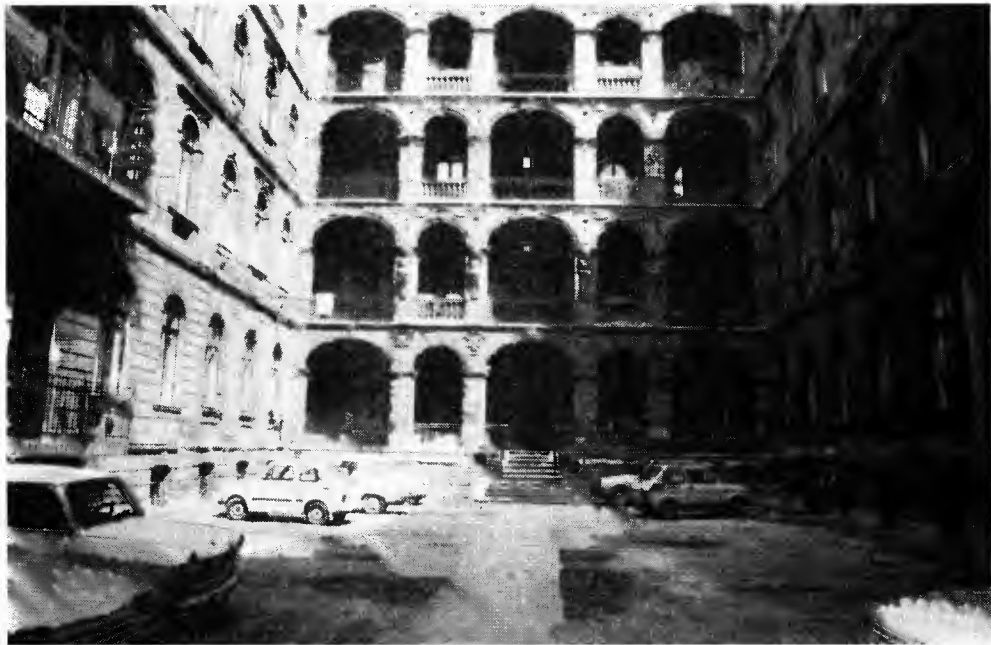
Andrássy út környéki épületekkel vetekedő nagyvárosias polgári bérház (Bezerédi utca 6.)
