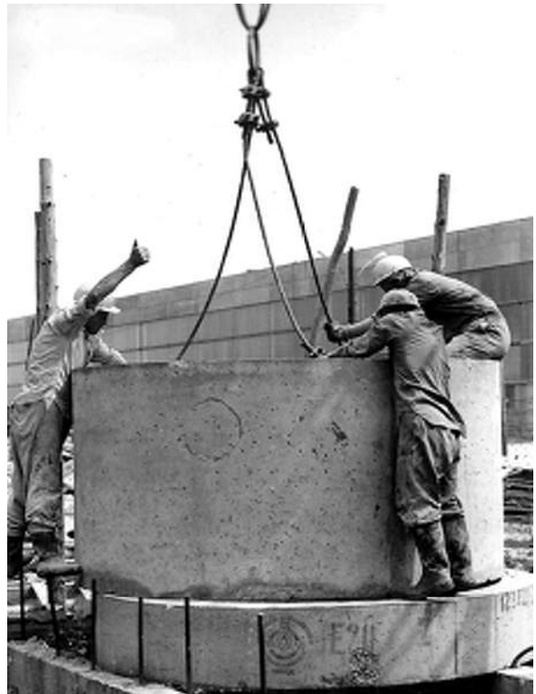
4. kép: Aknaelemek illesztése
