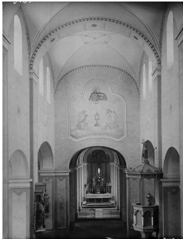
28. A bővített templom főhajója kelet felé. Gerecze Péter felvétele, 1896–1904 (?). Magyar Építészeti Múzeum és Műemlékvédelmi Dokumentációs Központ, Fotótár, lemezszám: 3484.
