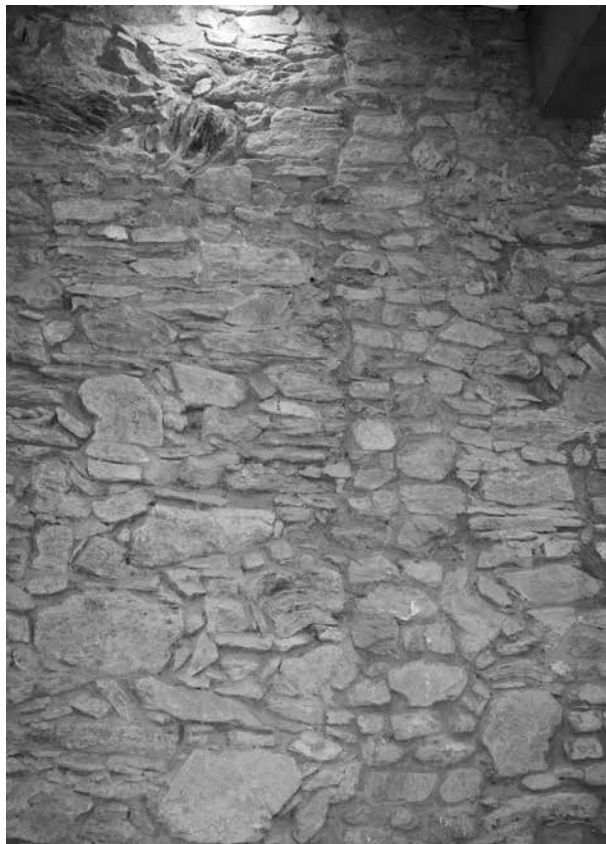
17. A földszinti nagyterem északi falán megfigyelhető függőleges falelválás (B. Benkhard Lilla felvétele, 2019)
