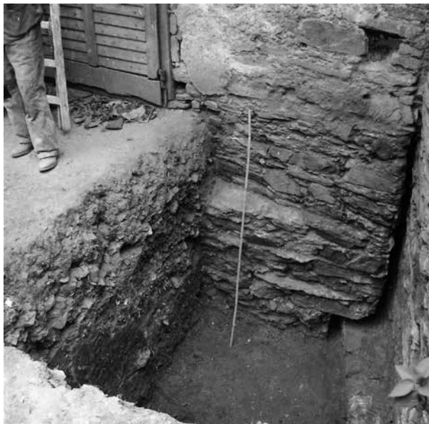
9. A déli és a nyugati városfal alapozásának csatlakozása 1963-ban Magyar Építészeti Múzeum és Műemlékvédelmi Dokumentációs Központ, Tervtár, Itsz. D 4369
