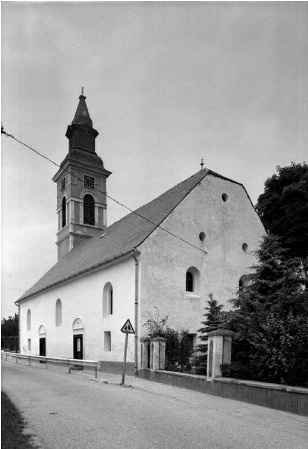
1. Balatonkenese, református templom, déli homlokzat. Fekete-fehér fényképfelvétel Magyar Építészeti Múzeum és Műemlékvédelmi Dokumentációs Központ, Fotótár, ltsz. 128.912N
