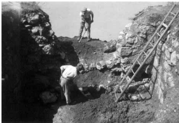
1. A vízparti torony feltárása 1937-ben A falkiromlásba épült be Schulek ikerablak-rekonstrukciója Visegrád, Mátyás Király Múzeum, Fotótár, neg. sz. 1608
