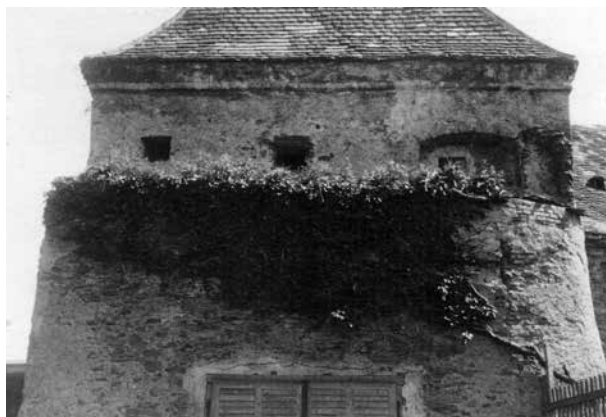
11. A déli városfal gyilokjáróját őrző északi homlokzat a 20. század elején Magyar Építészeti Múzeum és Műemlékvédelmi Dokumentációs Központ, Fotótár, ltsz. 10339P
