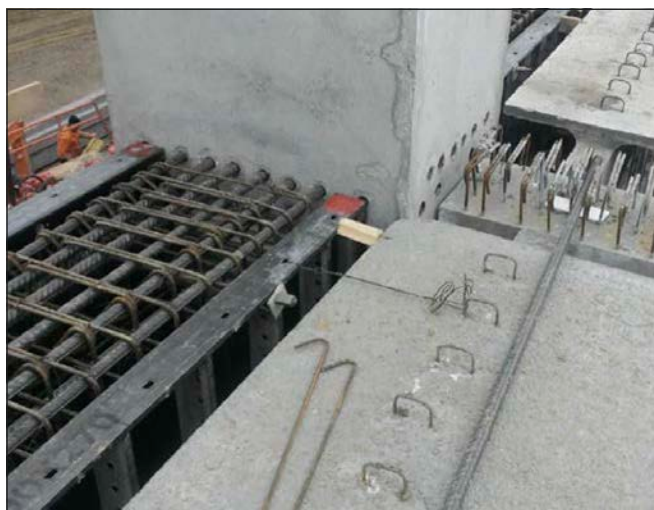
15. ábra: Lágúvasak elhelyezése a kapcsolat felső részén
