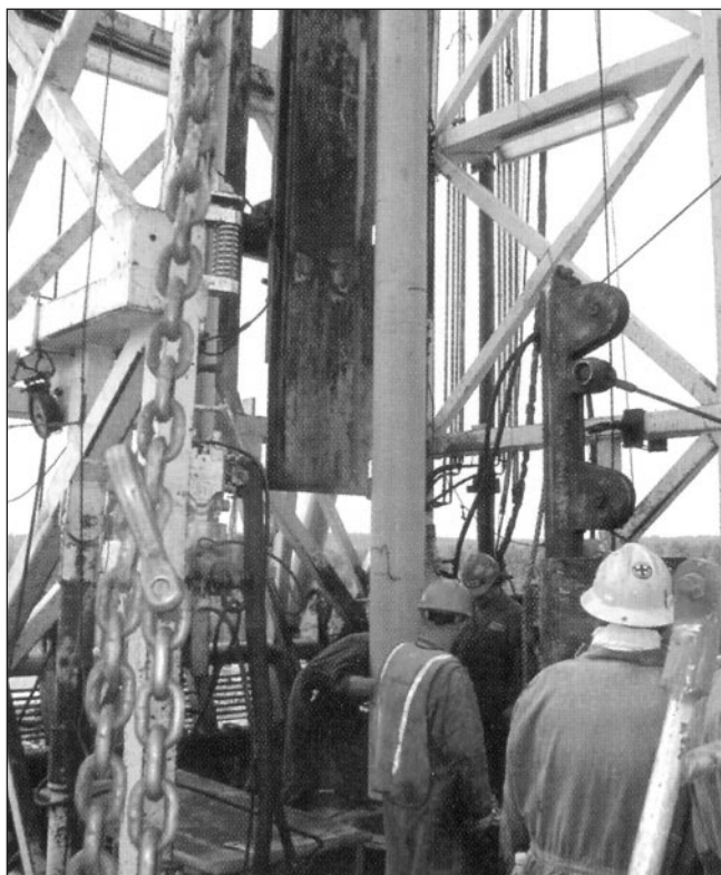
28. ábra: Egyátmérőjű/egyfuratú tágítható betétcsőrendszer beépítése
