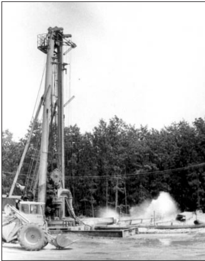
Kép: L10-es fúróberendezés működés közben
