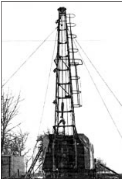
5. kép: Átalakított UKB–500-as fúrótorony Kővágószőlősen
