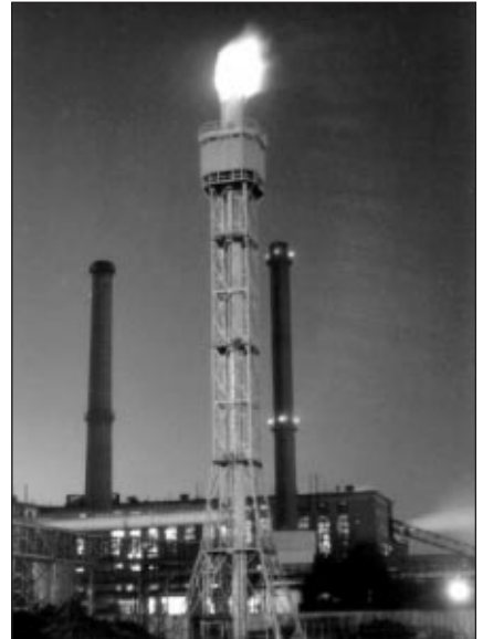
■ 6. ábra. Nagyteljesítményű kohógáz fáklya
