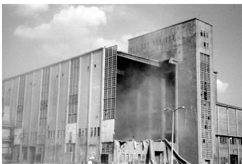
Az Inotai Hőerőmű főépület nyugati végfalának kidöntése robbantással 1999. július 19-én.
