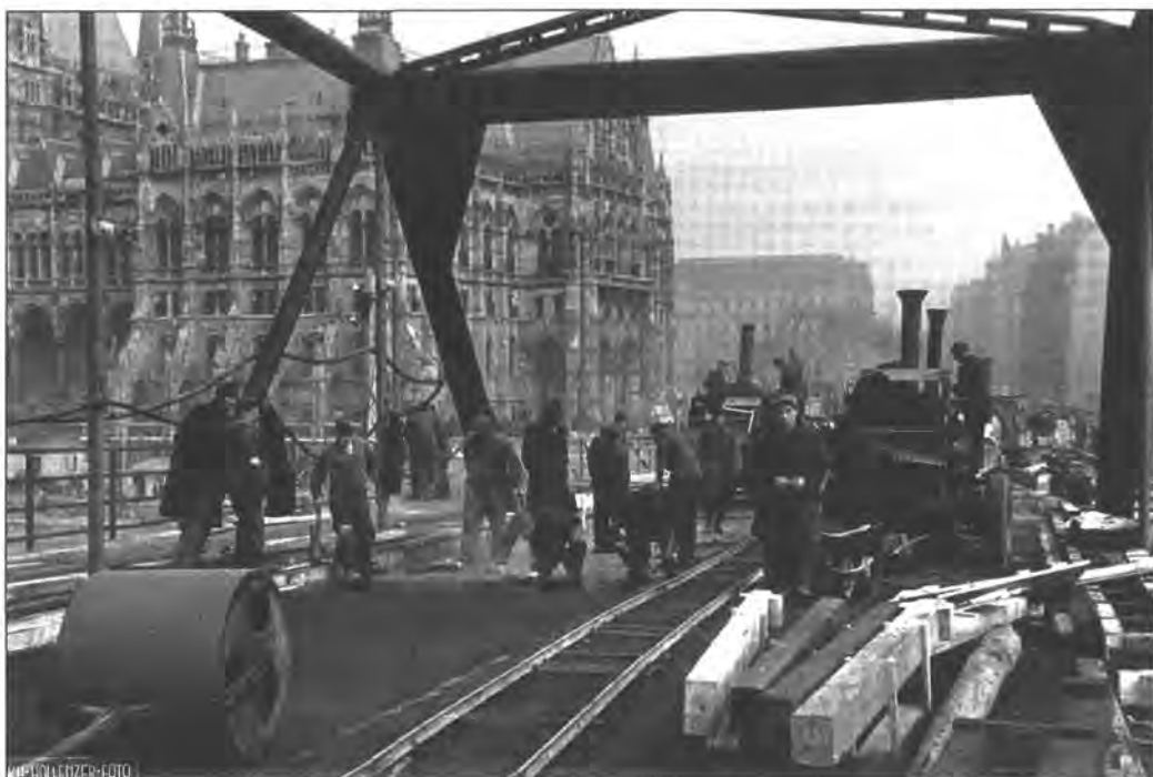
3. kép. A Kossuth híd hegesztett acélcövekből és szegecselt fatartókból álló szerkezetének építése, 1945 (fotó)
