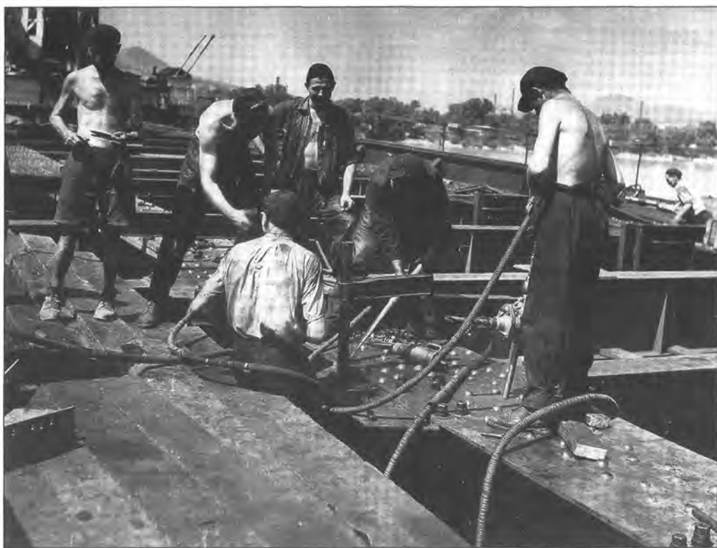
5. kép. Az Árpád híd vasszerkezetének szerelése, 1950 (fotó)
