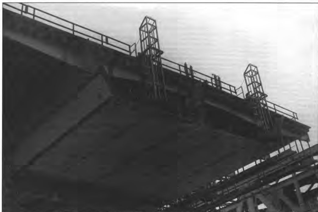
4. kép. A Lágymányosi Duna-híd építése: a felszerkezet szerelése, 1994 (fotó)
