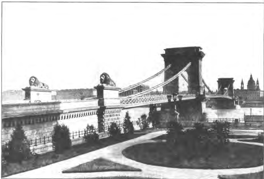
1. kép. Az eredeti Lánchíd, a Clark-féle vasszerkezettel, 1910 k. (fotó)
