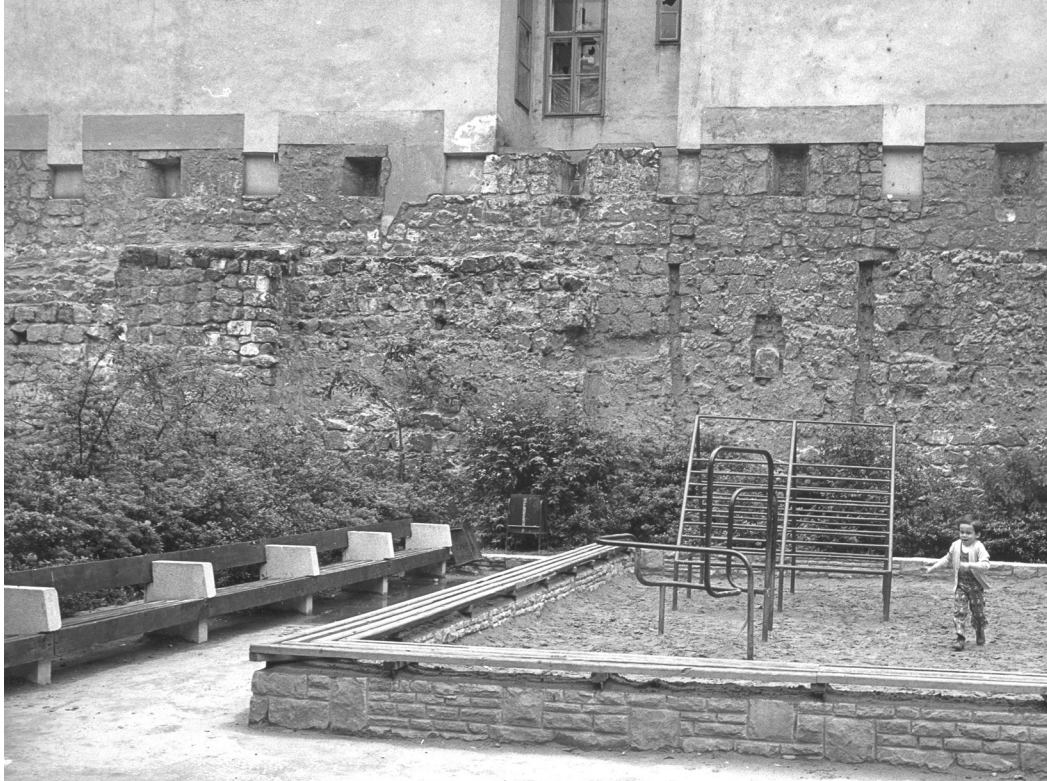
72. V. Bástya utca 1–3. A 15. századi városfal helyreállított belső oldala, 1970-es évek. Fotó B.M., 1973
