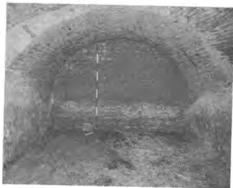
Az épület keleti szárnyában feltárt középkori mélypince lefalazott északi vége
