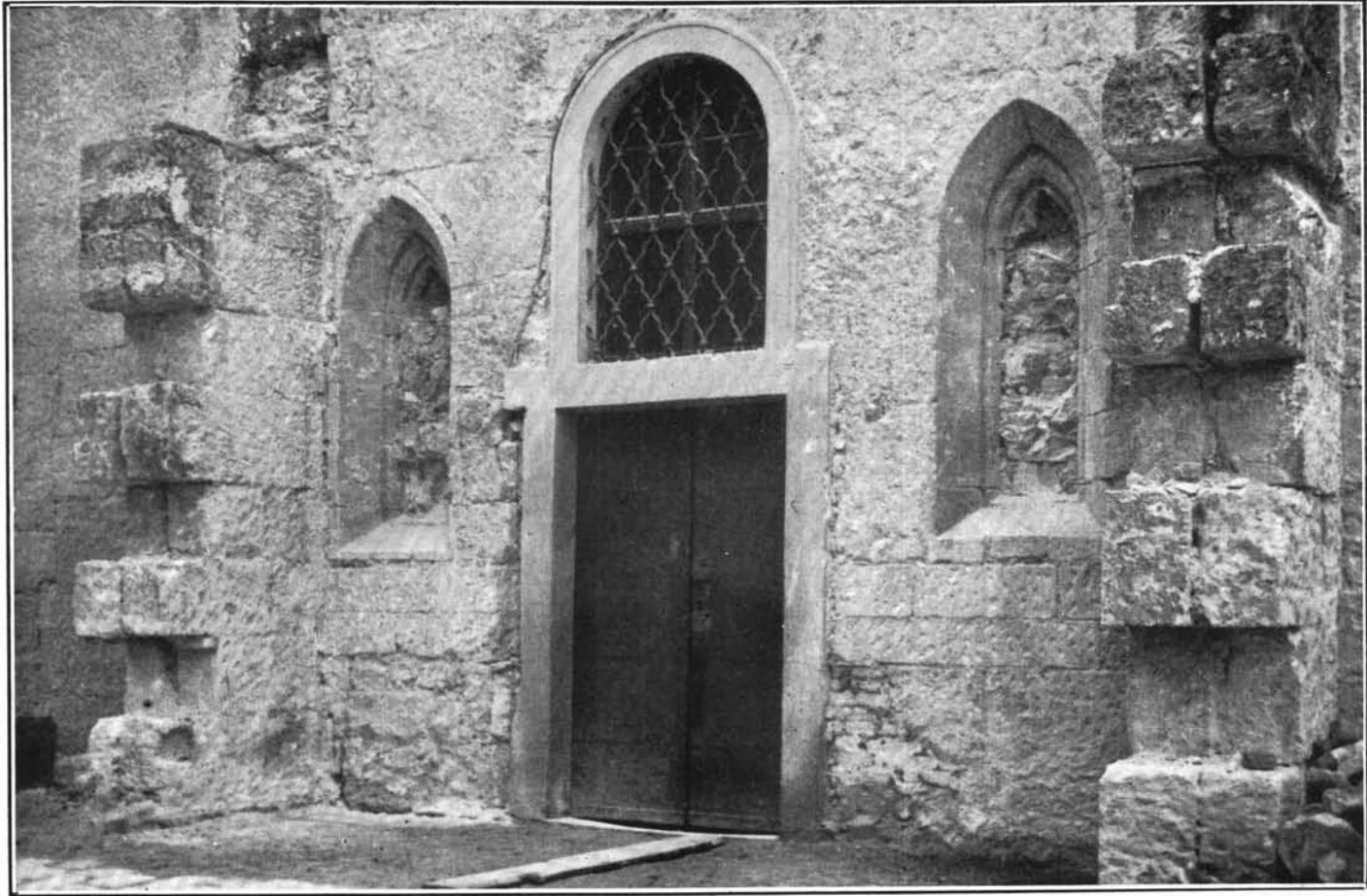
11. A sekrestye előcsarnokának bejárója és vakolattól megtisztított homlokzata.
