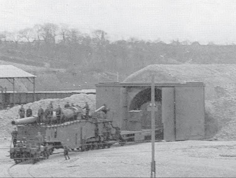
22. ábra. Hadimozdony tolja ki a K5 típusú vasúti löveget Franciaországban, az Atlanti Fal egyik pajta alakú fedezékéből. A fedezék fedőneve: Dom Bunker
