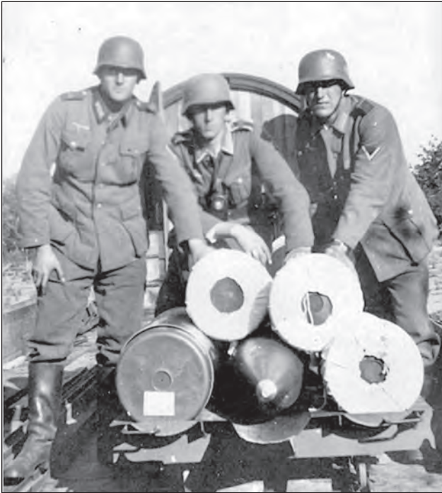
25. ábra. A K5 típusú vasúti löveg osztott lőszerének szállítása egy vasúti kocsin
