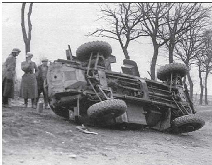
10. ábra. A felborult páncélfelderítő alján láthatóak a négykerék-hajtás és négykerék-kormányzás részlei
