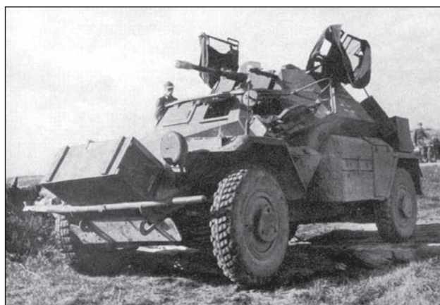
12. ábra. A Sd.Kfz 222-es páncélfelderítő, a tornyán a cikkben említett – itt nyitott – védőhálójával, azon pedig az eső vagy napsugárzás ellen védő ponyvával
