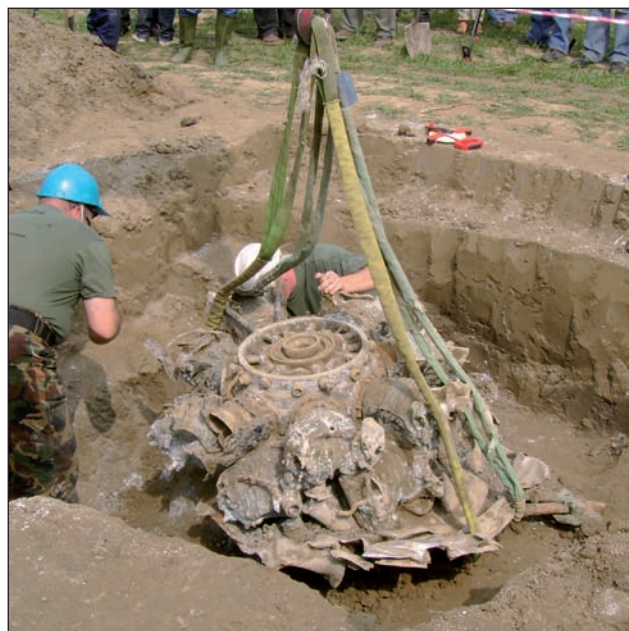
4. ábra. A motor alá hevederezése
