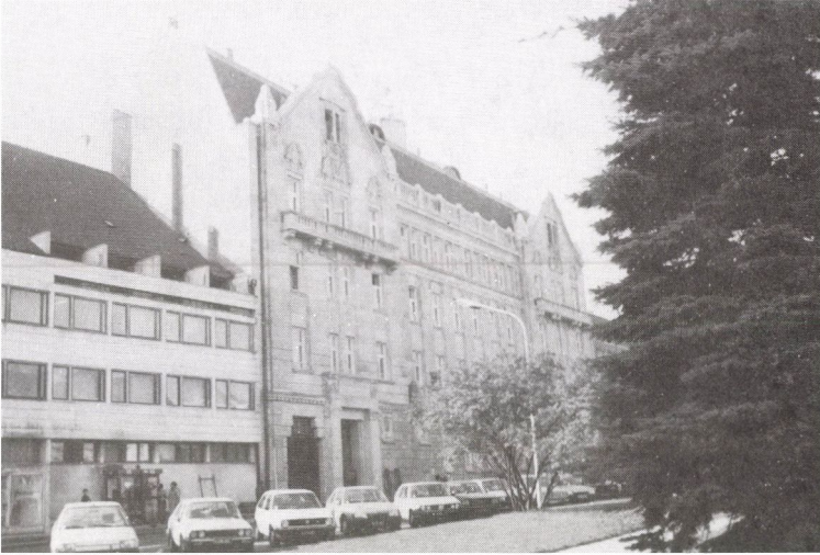
2. ábra. A ZKF alkalmazása teljes épülethomlokaton (Sopron, Posta palota, Széchenyi tér 7--10. -- 1989)
