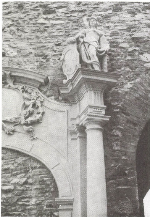
6. ábra. A Zeughaus-kapu helyreállítás után. Példa az in situ konzerválás komplex feladatára. Rendkívüli nehézség a befalazott állapot az erősen nedves heterogén falazatban
