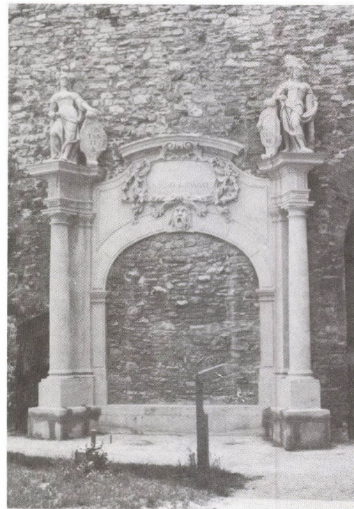
6. ábra. A Zeughaus-kapu helyreállítás után. Példa az in situ konzerválás komplex feladatára. Rendkívüli nehézség a befalazott állapot az erősen nedves heterogén falazatban
