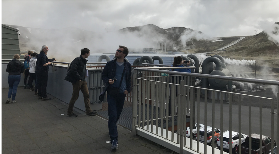
Figure 2. Observing steamy landscapes at Hellisheiði geothermal power station (Photo: Madalina Sbarcea) 2. ábra Gőzölgő táj megtekintése a Hellisheiði geotermális erőműnél (Fotó: Madalina Sbarcea)
