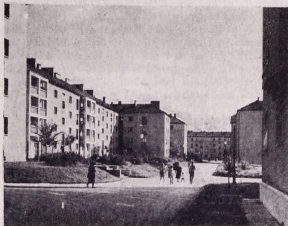
Alacsony lejtésű területen rézsűk alkalmazása tagolt belső udvarokat eredményez. Kazincbarcika (MTI foto)
