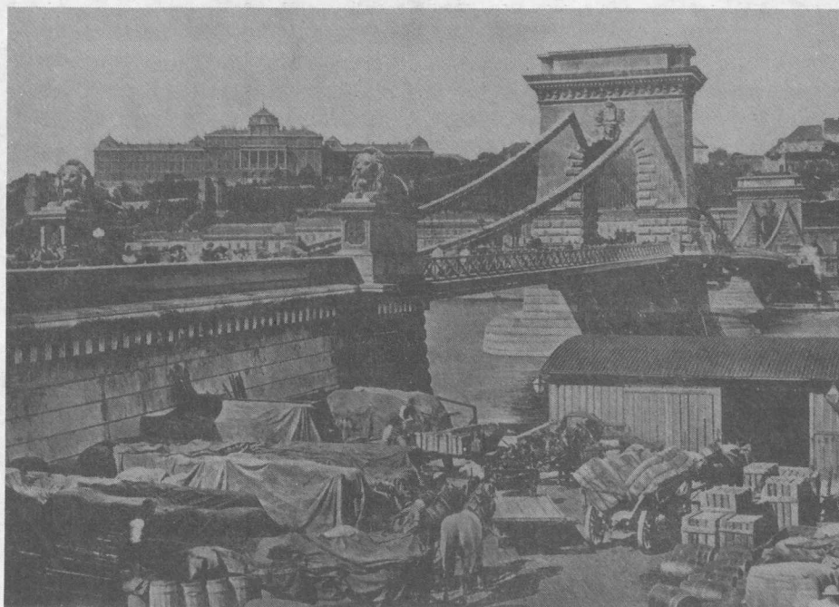
1. ábra: A Lánchíd eredeti vasszerkezete. A függesztőrudak a mainál kétszerre sűrűbben voltak elhelyezve. A kép előterében a Dunagőzhajózási Társaság rakodója, háttérben a budai Várpalota, a múlt század végi átépítés előtti állapotban.
