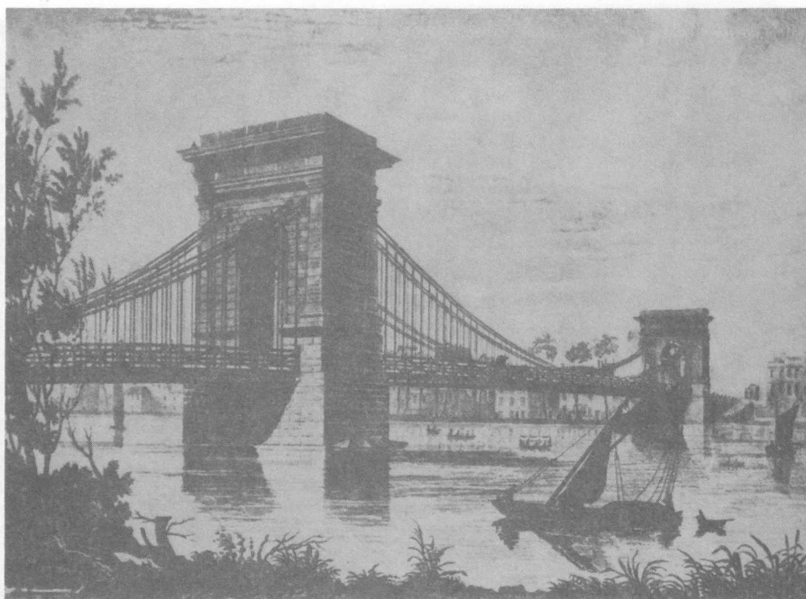
4. ábra. A Pest-budai Lánchíd egyik előképe: a William Tierney Clark tervezte lánchíd a Temzén, London Hammersmith városrészében
