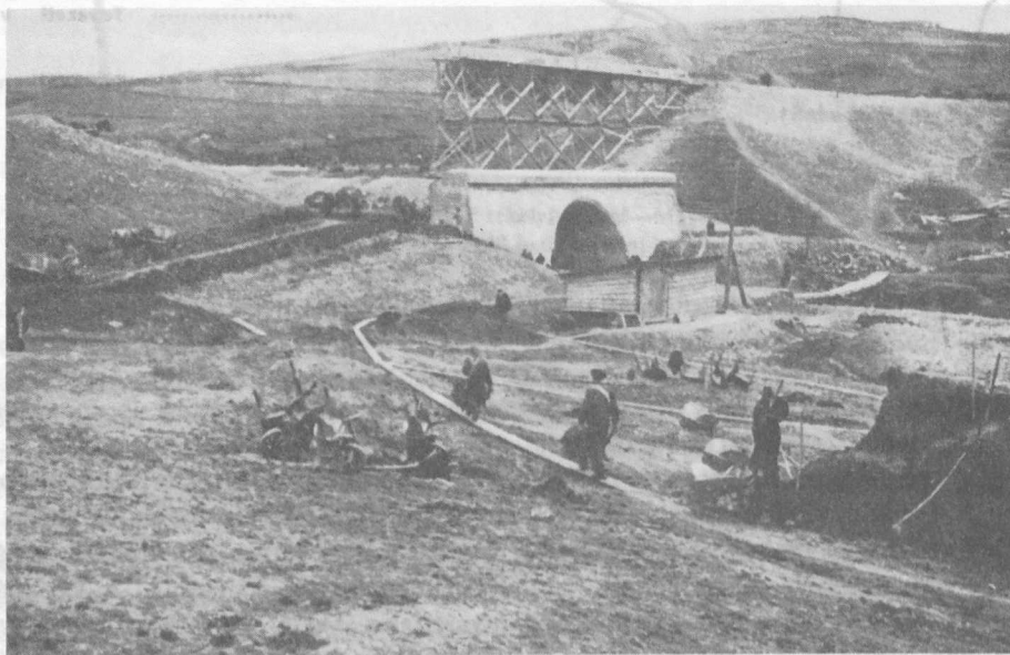
4. sz. ábra: Töltésépítés
