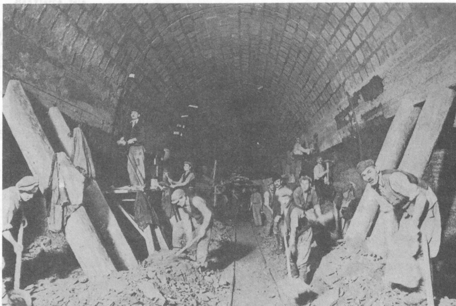
6. sz. ábra: Az alagút falazása
