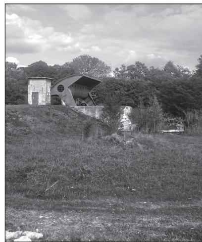
Használaton kívüli vízszabályozó műtárgy Monostorszegh közelében
