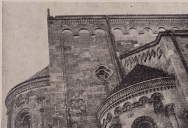
6. ábra. A hosszház északról.
