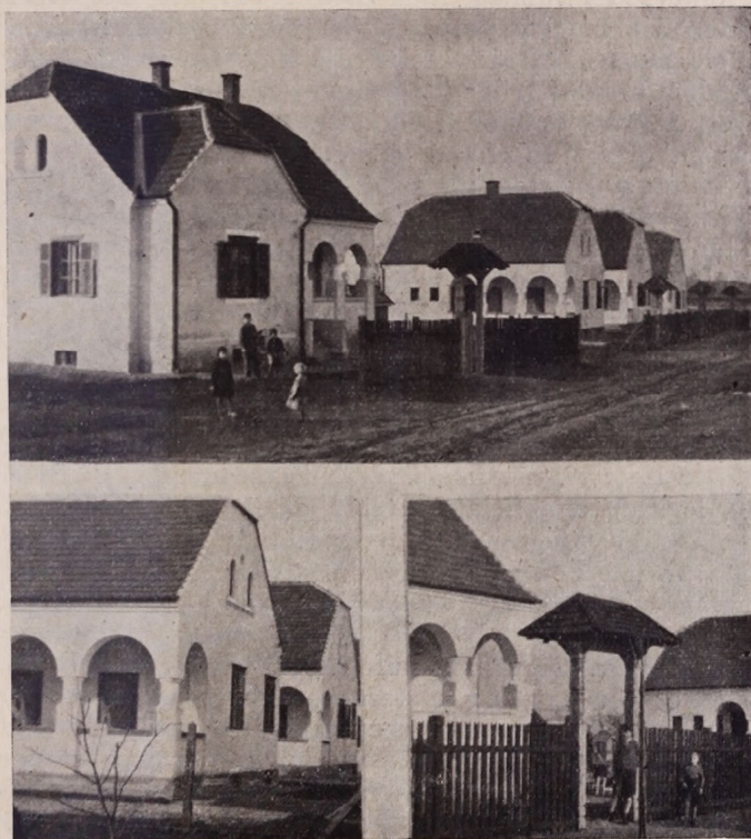
3/a ábra. Új utcakép: vitézi szer Szombathelyen, épült 1938-ban; részletfelvételekkel. — Bild einer neuen Gasse: Heldentrakt in Szombathely (gebaut im Jahre 1933.)
