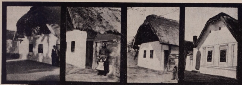
9. ábra. Szt. István kir.-u. 22. sz. ház utcai homlokzata. — 10. ábra. Szt. István kir.-u. 22. sz. ház faragott kapubálványa. — 11. ábra. Szt. István kir.-u. 54. sz. ház (volt kanászház) utcai képe. — 12. ábra. Szt. István kir. u. 13. sz. ház utcai homlokzata. (Alaprajza: 17. ábra.)
