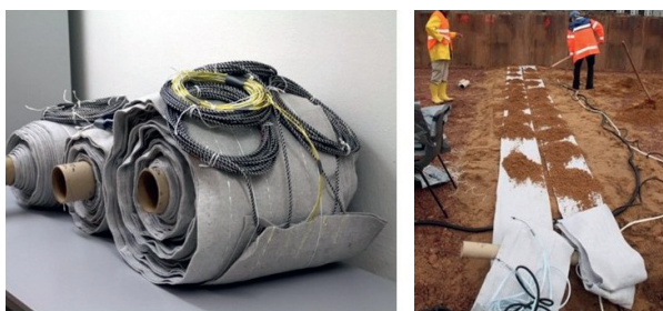
8. ábra. Jeladásra és továbbításra alkalmas innovatív textilszerkezet felépítése és elhelyezése
