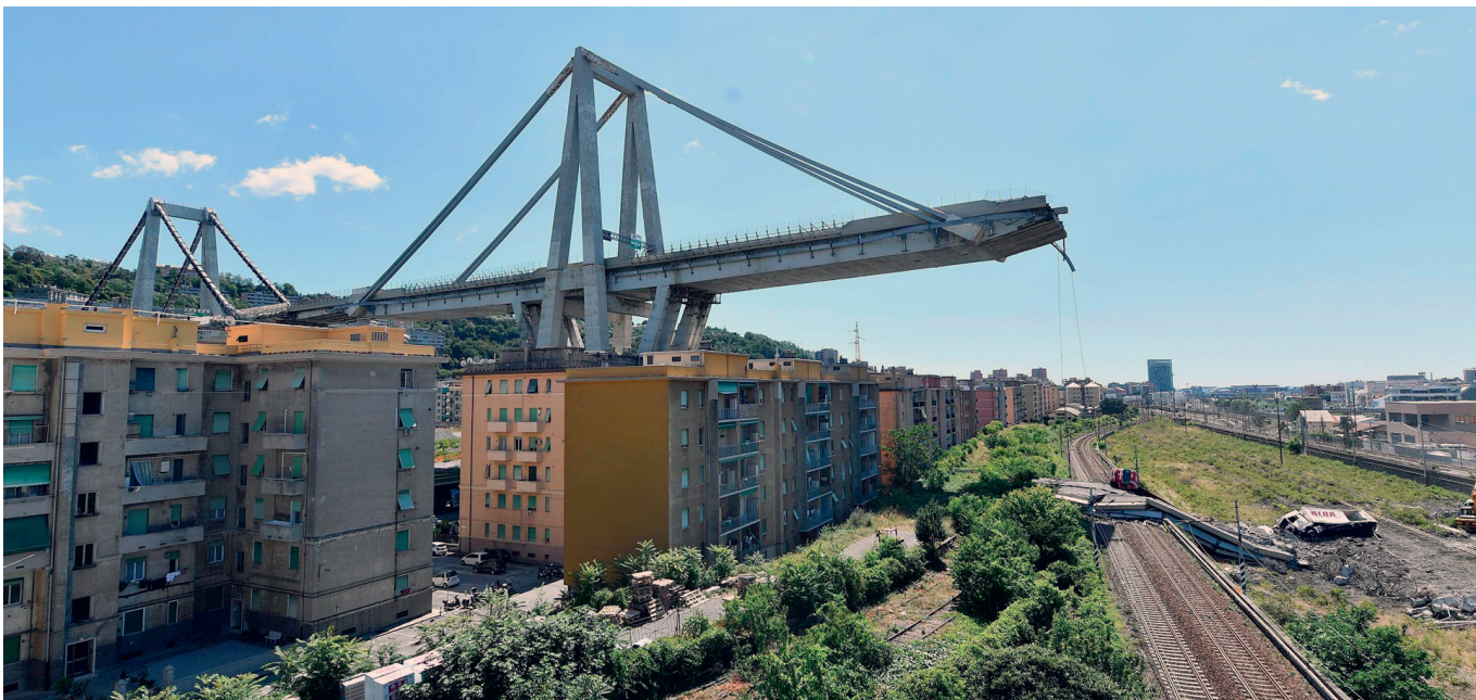
1. ábra. A genovai, 1967-ben elkészült A10 olasz autópálya viaduktjának 2018. augusztus 14-i összeomlása
