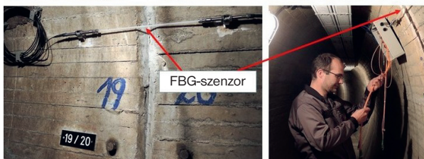
9. ábra. FBG-érzékelővel monitorozott gát Ausztriában
