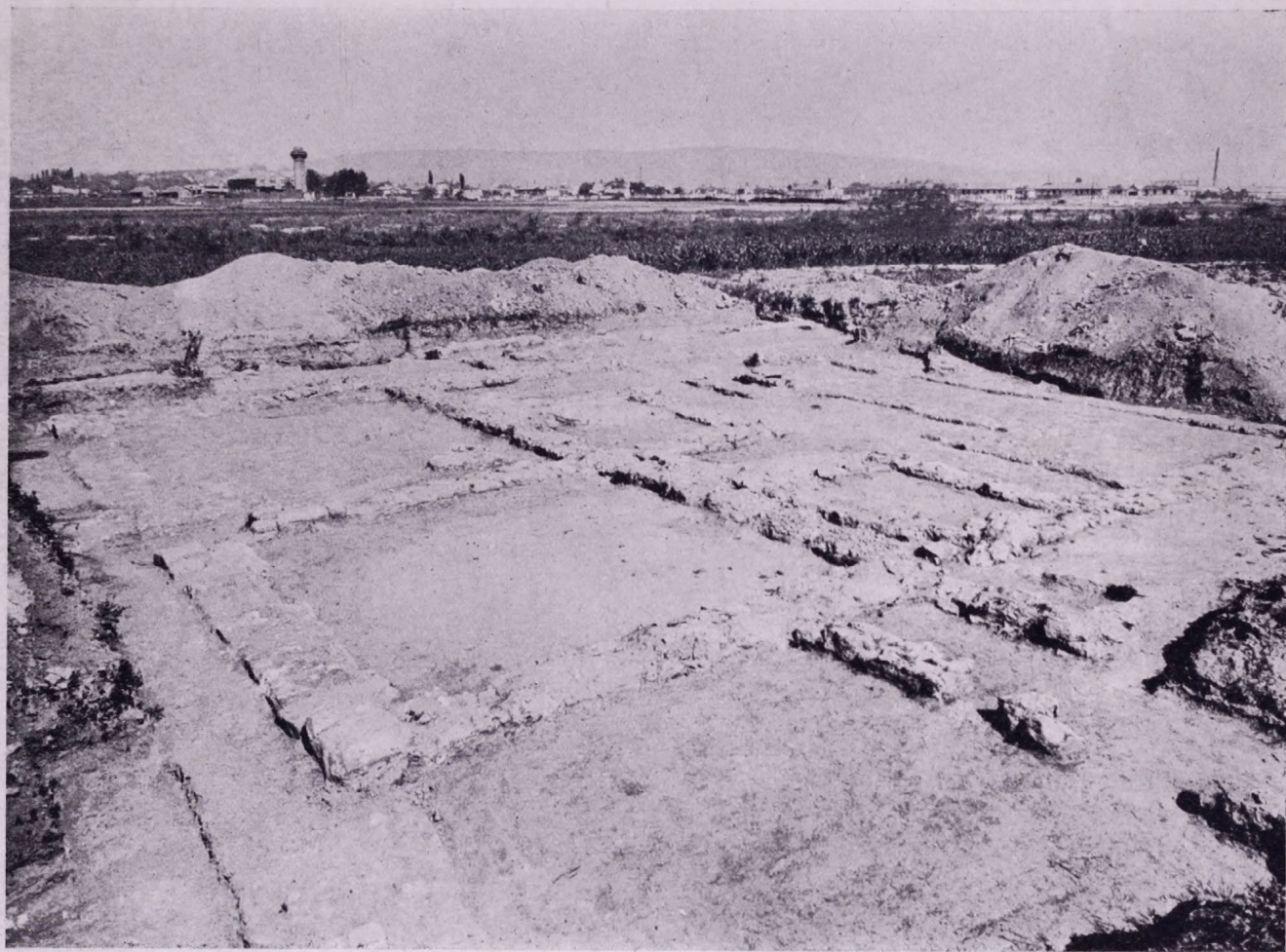
7. kép. A VIII. számú épület délkelet felől nézve.
