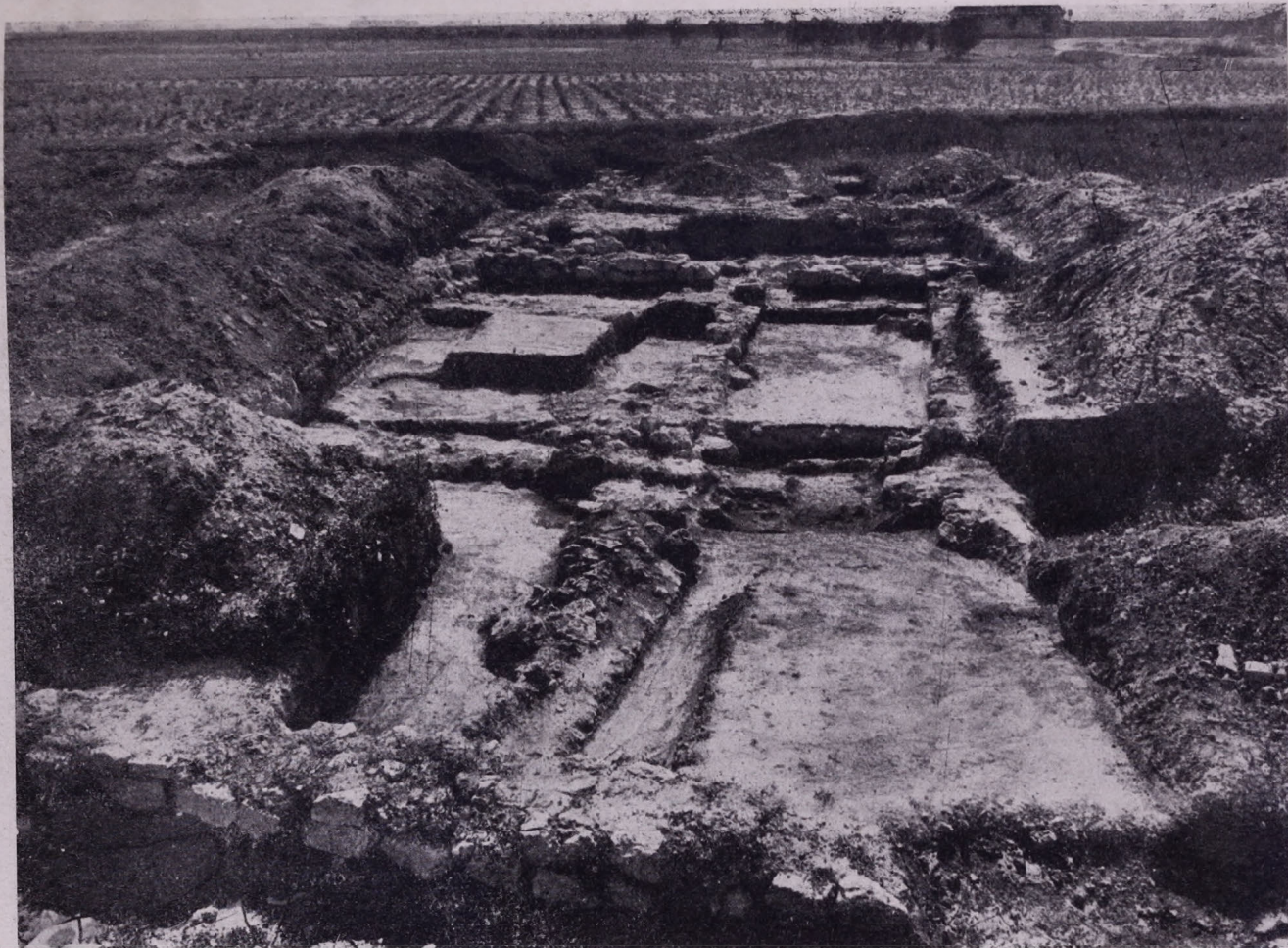
2. kép. Az I. számú épület maradványai nyugat felől nézve.
