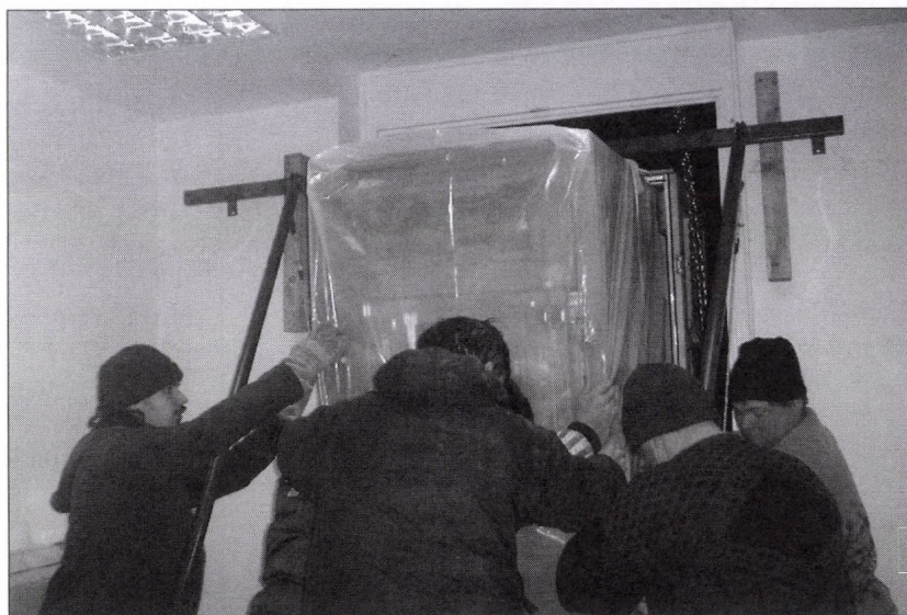
1. ábra: Az IBM Regatta p690 szerver OMSZ géptermebe való beemelésének két mozzanata
