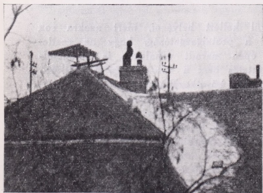
6. ábra. A reáliskola tetején levő vas-telefonoszlop, melyet a vihar derékszögben hajlított meg. (Pósta felvétele.)
