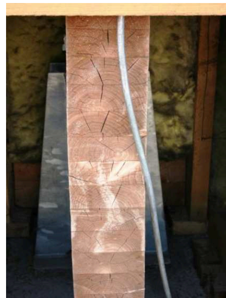
4. ábra A tapolcai rendezvénycsarnok repedt tartójának bütüje
