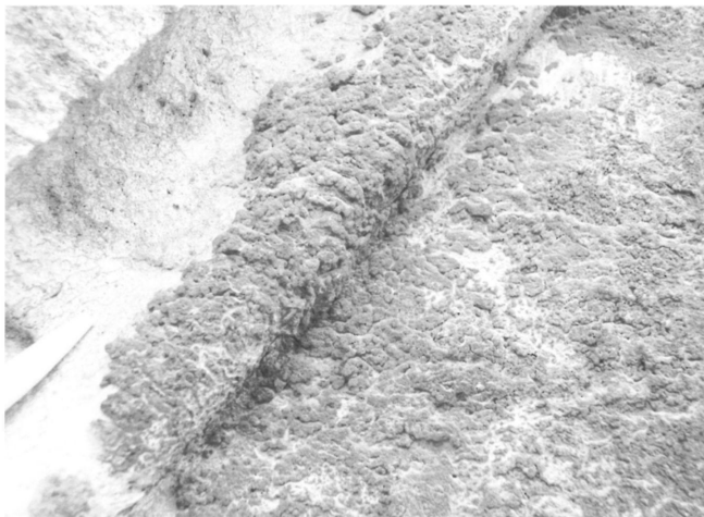
4. ábra. Fekete gömbös mállási kéreg a travertínó felületén (Mátyás templom, oldalbejárat)
