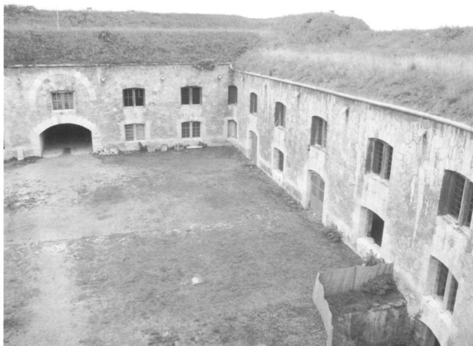
1. ábra. A komáromi Monostori erőd falazata „almásneszmélyi” travertinóból épült a XIX. sz. második felében
