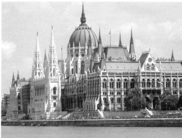
3. ábra. Az Országház nyugati és déli homlokzata a travertínóra cserélt két kőtoronnyal és a még durva mészkőből álló sötétebb déli homlokzati részzel
