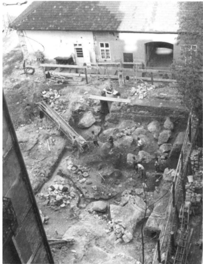
1. fénykép. A Franklin lépcső 2. építésének alapgödre 1970-ben, fotó Főmterv, DOMONKOS Endre
