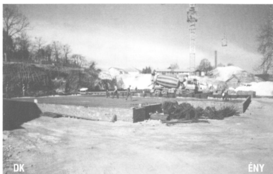
1. fotó. Az építési terület 2001. februári állapota Photo 1 Groundwork in progress, in February 2001
