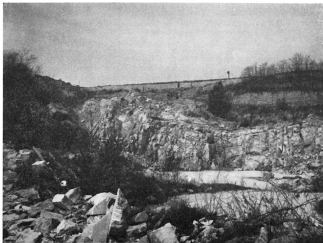
2. ábra. A fekéü egyenlötlen megsüülydedéséből származó behajlasi forma (látszólagos szinklinális) Süttönél
