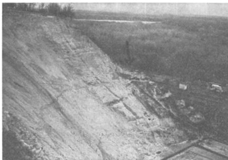
5. ábra. A paksi téglagyárnál megfigyelhető íves csúszólapú mozgás lépcsői
