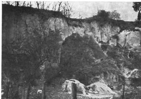
13. ábra. Leszakadásos csúszás Dunakömlődönél Abb. 13. Verrutschung bei Dunakömlöd
