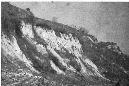
7. ábra. Előtér-nélküli megcsúszott partszakasz típus képe
