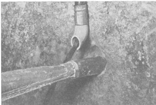
2. ábra. Távhőmérő berendezés átvezetése a falon — Провод через стену аппарата дальномера — Transduction of the telethermometer apparatus through the wall
