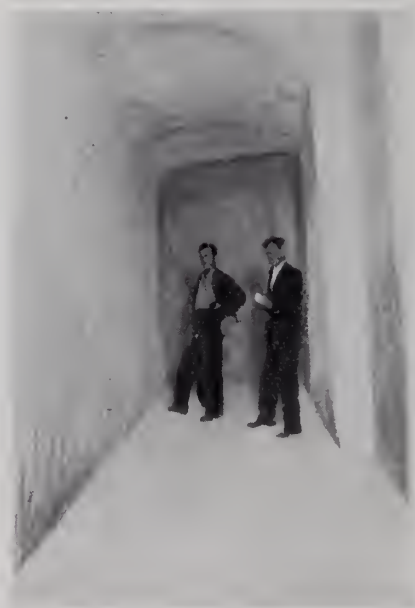
Fig. 36. ábra. Részlet a Derekaszegi bánya belsejéből. A tárna egymással párhuzamosan, illetve egymásra merőlegesen futnak a hófehér kaolinban. — Detail vom Inneren der Grube von Derekaszeg. Die Stollen verlaufen parallel, resp. senkrecht zu einander in schneeweißem Kaolin.
