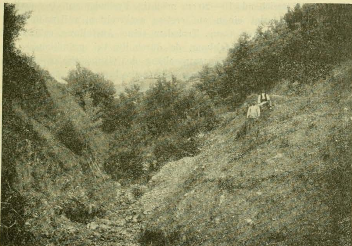
Fig. 3. Eingestürztes Mundloch der Zinkgrube im Kolibigraben.
