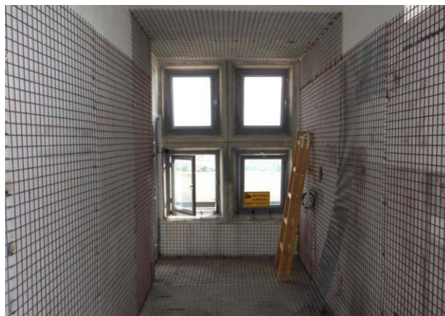
4. ábra. A vezérlőállomást védő Faraday-kalitka építése [1].
