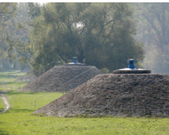
Ivóvizet szolgáltató parti szűrőszűtők az újpesti Duna parton FOTÓ | MTI - FÜZESI FERENC
