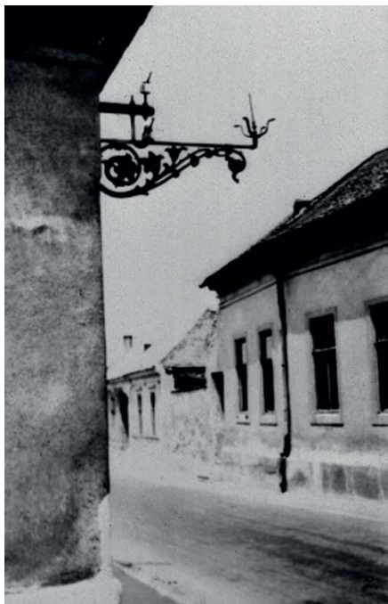
Tatai acetilénos közvilágítás
