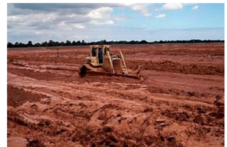
Munkagép egy száraz felhalmozást alkalmazó vörösiszap-tározóban
