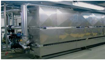
A TH-rendszer hőcserélőinek kezelőbarát, moduláris elrendezése
