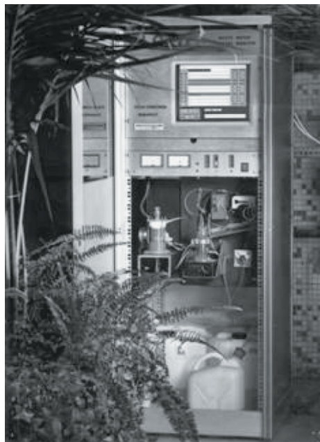
6.Ábra. Az Aqua-Concorde Kft. által készített nehézfém-monitor prototípusa a Föv.Csat.Művek Észak-Pesti szennyvíztelepén (1995).
