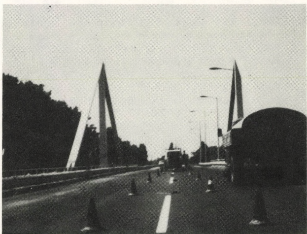
2. ábra. Egy mérési helyszín a mérőkocsival és a híd dinamikus gerjesztésére szolgáló locsoló autóval
