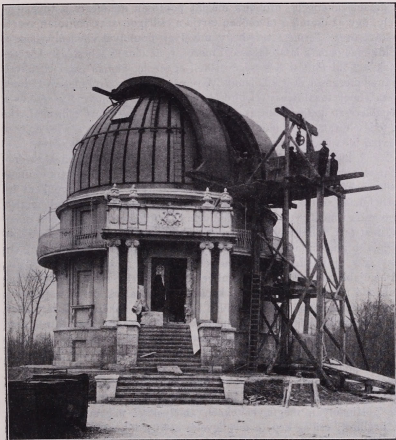
28. A reflektor alkatrészeinek beemelése a kupolába.
