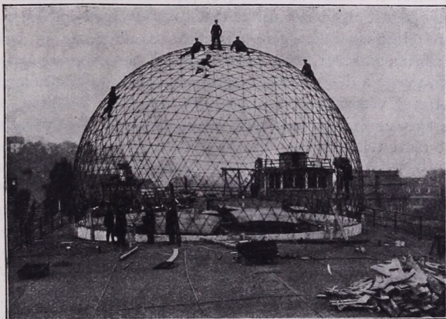
9. A Zeiss-féle kísérleti kupola vasdróthálózata.
