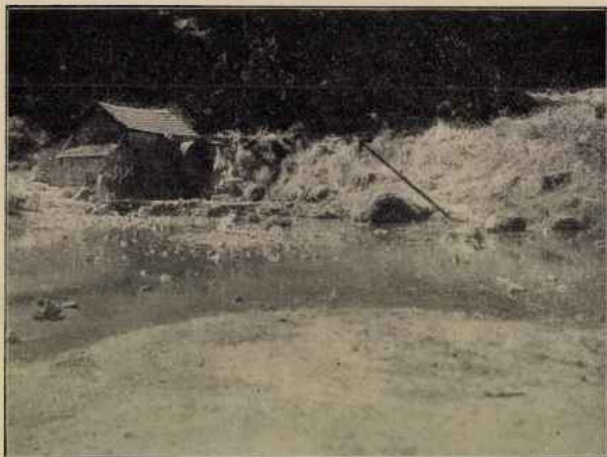
4. kép. Kétköves malmot hajt a nyíllal jelzett helyen fakadó bűvópatak. (Szerző felvétele.)
